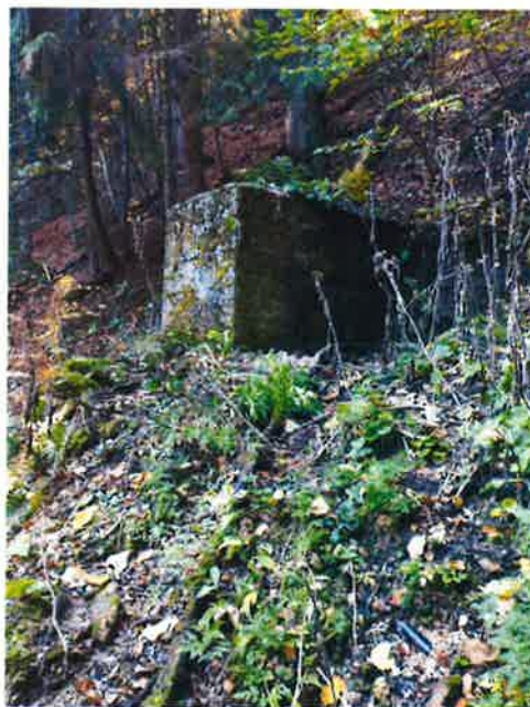
Slika 13: Sabirna komora – rezervoar
